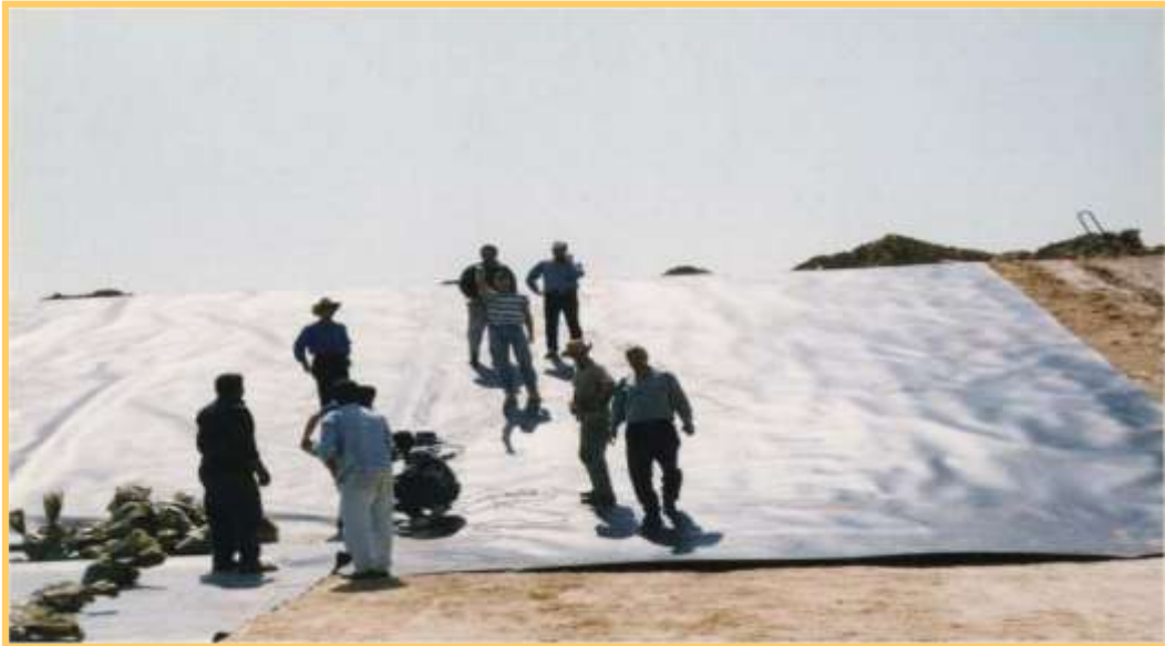
شكل (3.17) إضافة طبقة عازلة من رقائق البولي اثيلين
